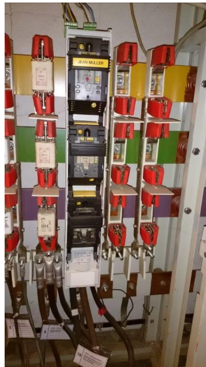
Slika 2: Ugrađena rastavljačka letva na mesto postojeće
