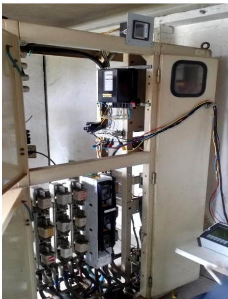
Slika 5: Topljivi osigurači u naponskom kolu
