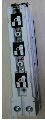
Slika 1: Rastavljačka letva sa zadnje strane
